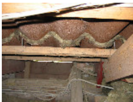
Mineraluld anvendt som stopning
