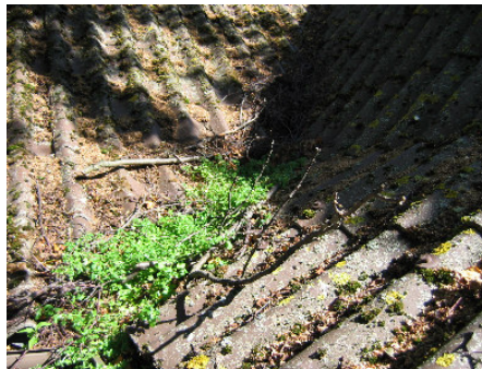
Skotrende i tagfladen som ikke er oprenset
