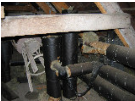
Bøjninger på van/varmerør er ikke isoleret
