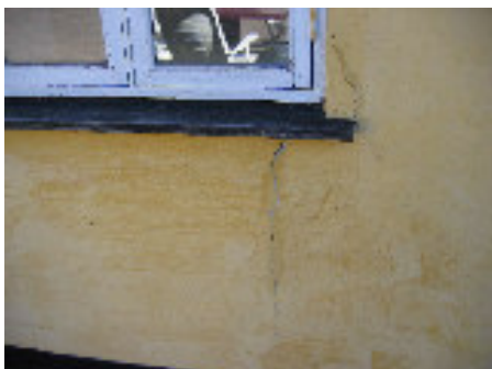
Revne i facaden ved vindue
