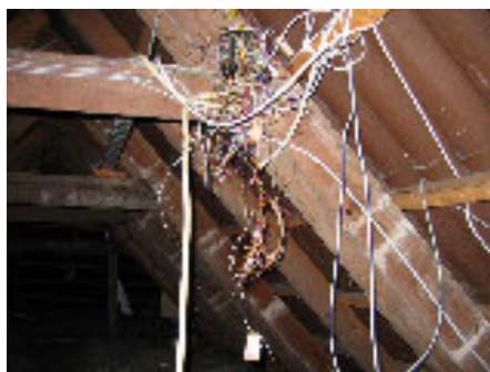
Installationer i loftrummet (ikke el.)
