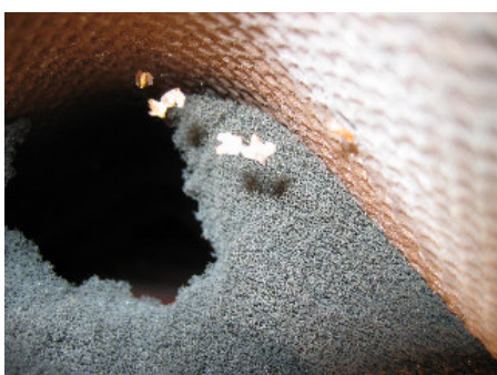
Skumklodser i tagfoden der er defekt
