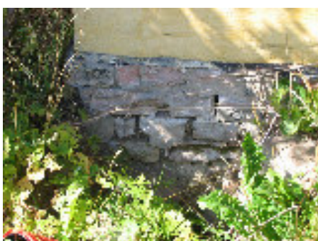
Muret sokkel uden sokkelpuds
