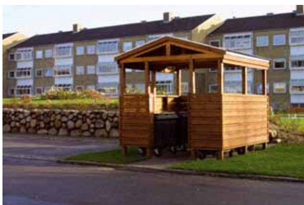
Affaldscontainerne har fået en god placering. Skuret kan overskues fra lejlighederne og er åbent, så man kan se ind og ud.
